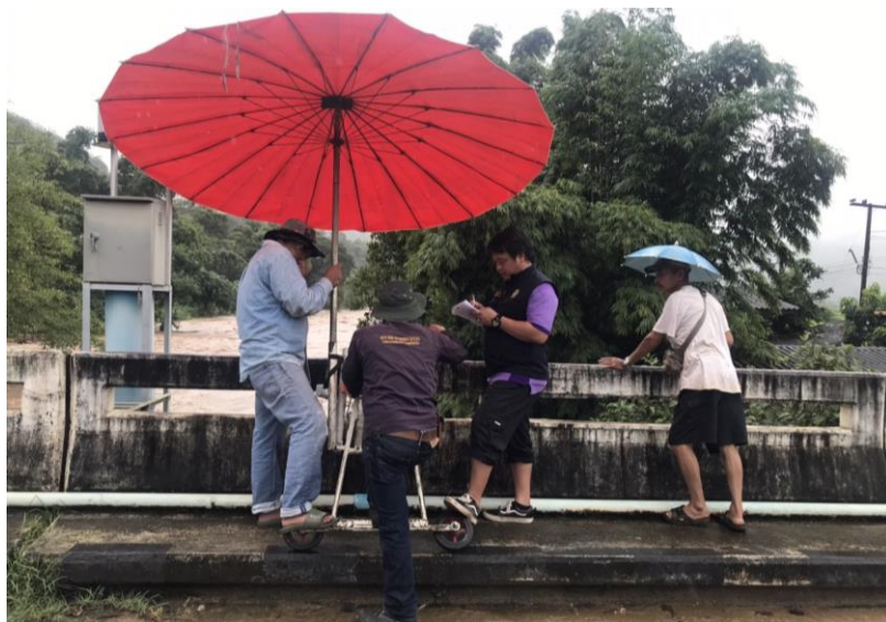
รูปที่ 5-7 ทำการสำรวจปริมาณน้ำและการสำรวจตะกอนแขวนลอยสถานี P.92 น้ำแม่แตง บ้านเมืองกุด อ.แม่แตง จ.เชียงใหม่
